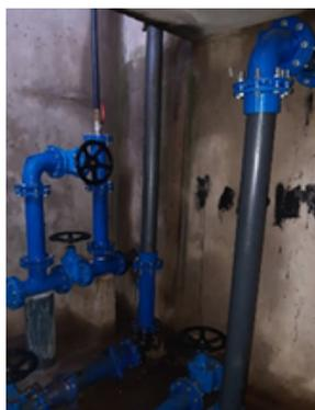
Un important chantier de rénovation, non prévu dans les projets 2022, s'est imposé à nous. Il s'agit du remplacement de toutes les canalisations et vannes du réservoir de Himeling.
